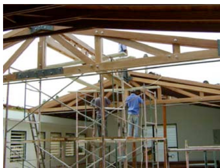
obra de rehabilitación de la cubierta de la casa de convivencias de las Misioneras de María Mediadora en Medellín
